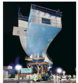
が担当する橋桁は、道路を支えるメインの部分。ブロックごとに鉄を切断溶接して仮組みし、錆びないように塗装します。それを現場でつなげて道路を作っていきます。道路ができあがっていくと、みなさんの生活を支えられていることを実感できます」
